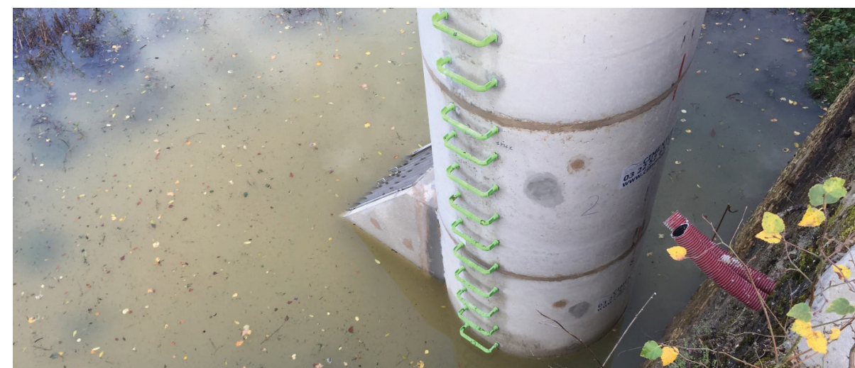
Automatisation du système de vannage - Étang du Moulinet (Rambouillet) - Décembre 2019
