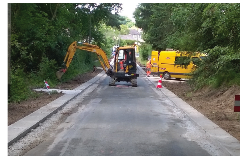
Travaux sur la Transcom 19 (Sonchamp) - Mai 2019
