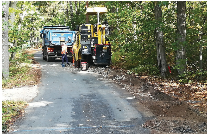
Travaux sur la Transcom 44 (Clairefontaine-en-Yvelines) - Avril 2019
